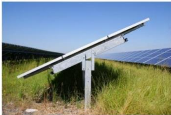
Fotografia 1 Przykładowa konstrukcja wsporcza modułów fotowoltaicznych (źródło: gramwzielone.pl)
