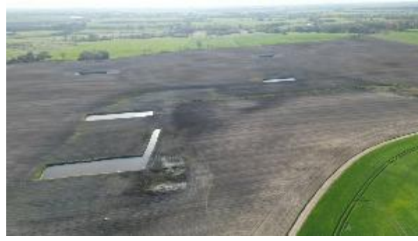
Fotografia 3 Zbiorniki wodne na terenie inwestycji
