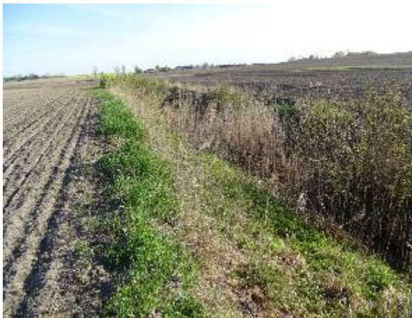
Fotografia 6 Rów melioracyjny na terenie inwestycji
